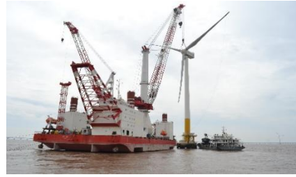
图 16 海上风电安装作业平台施工现场
